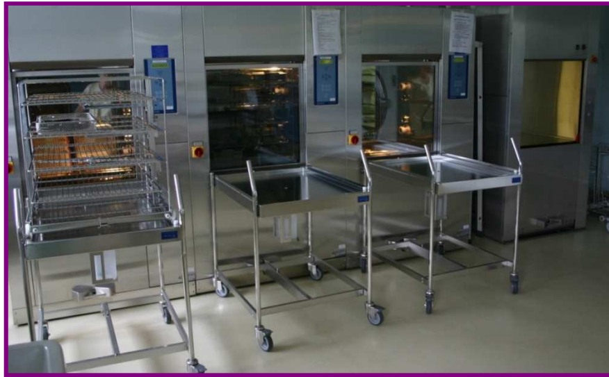
Mur technique de LD à double porte
